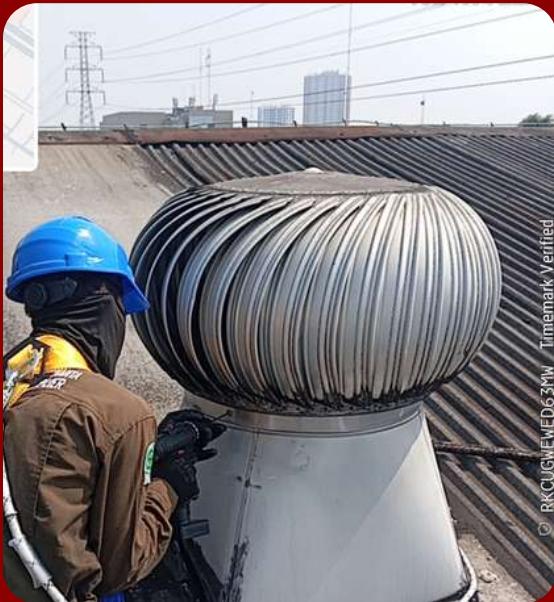
Perbaikan Ventilator Turbin
